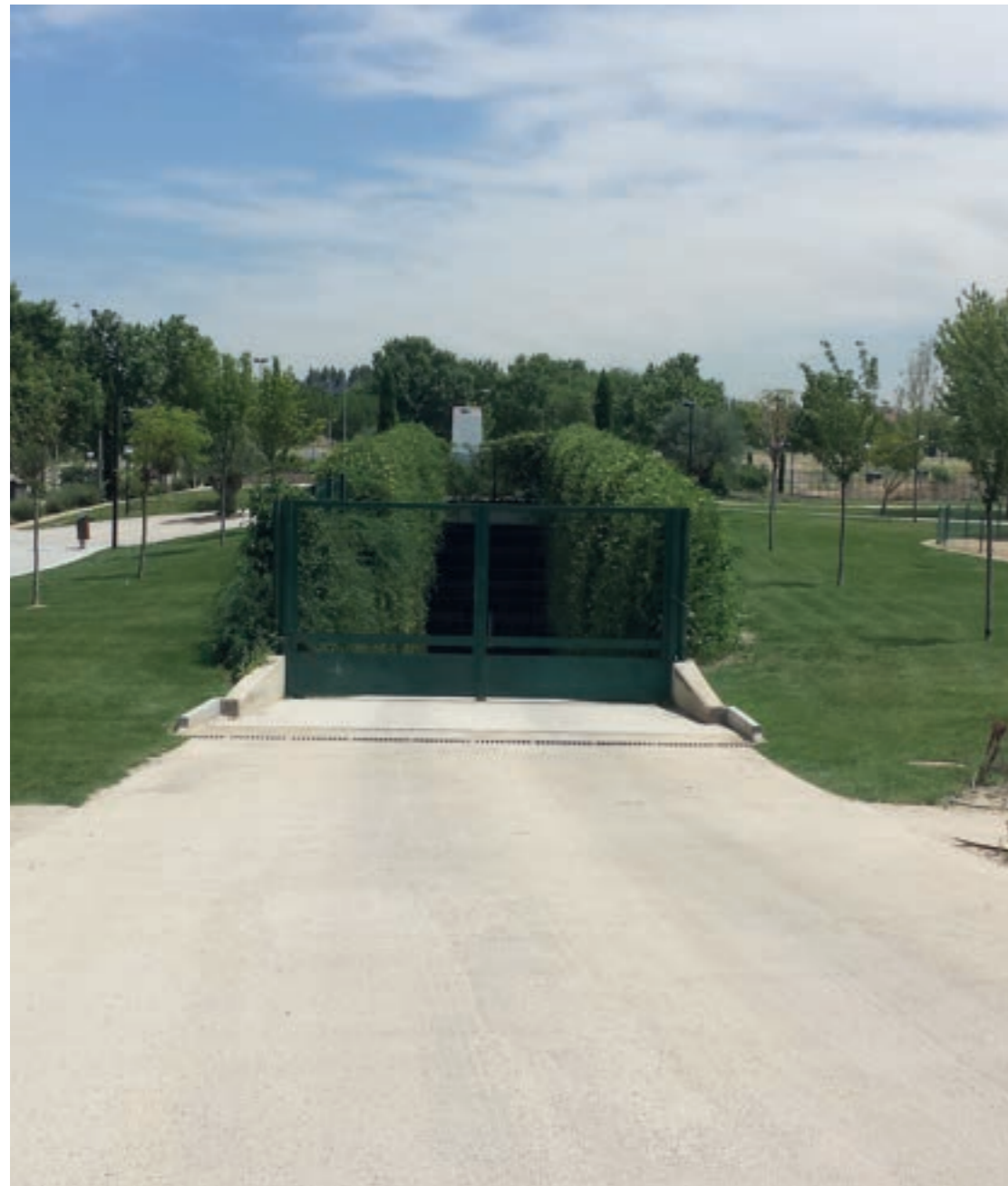
Collection station/terminal in Los Negrillos, Majadahonda Spain
